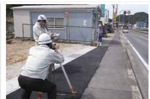
工事が終わると設計 どおりに工事が行われ たか確認するための検 査を行っています。
